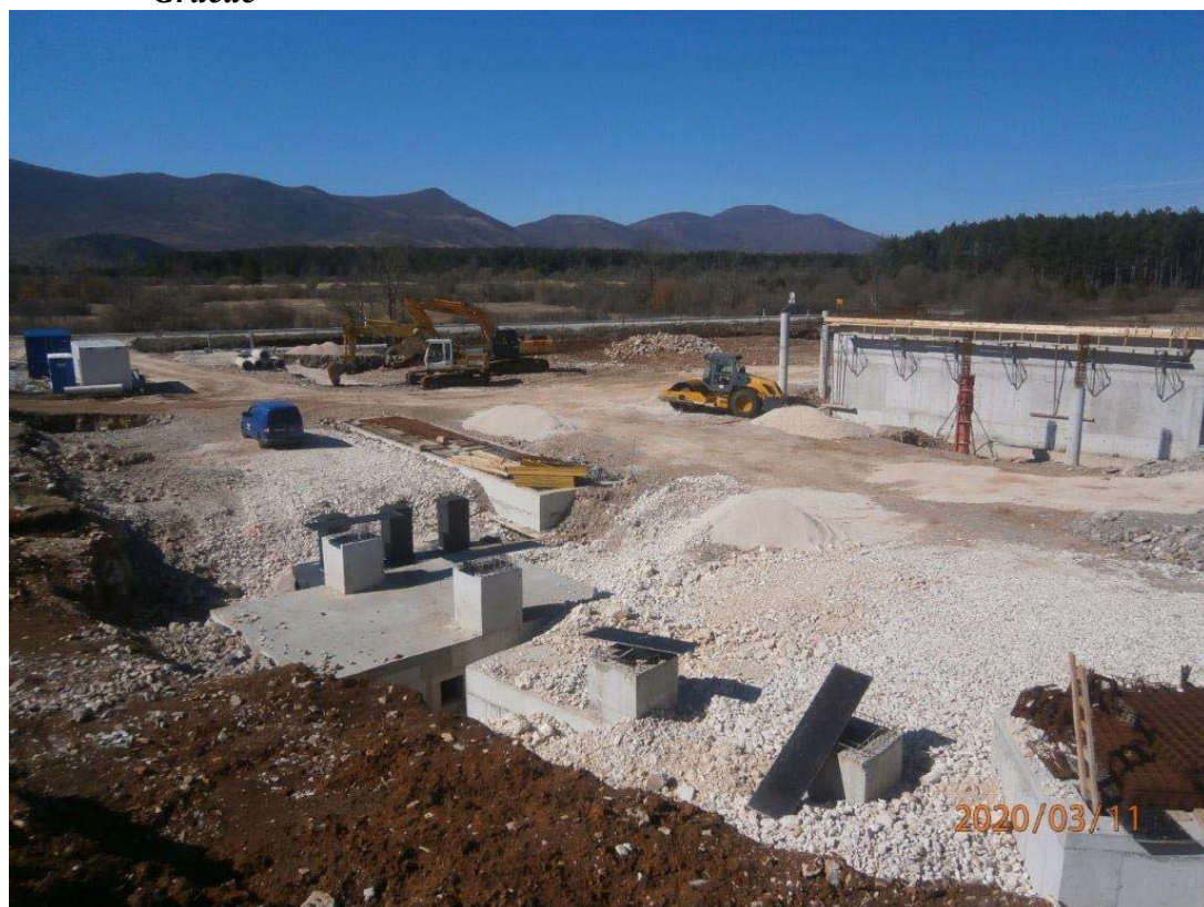
Slika 6: Izvođenje radova izgradnje pretovarne stanice i reciklažnog dvorišta Gračac
