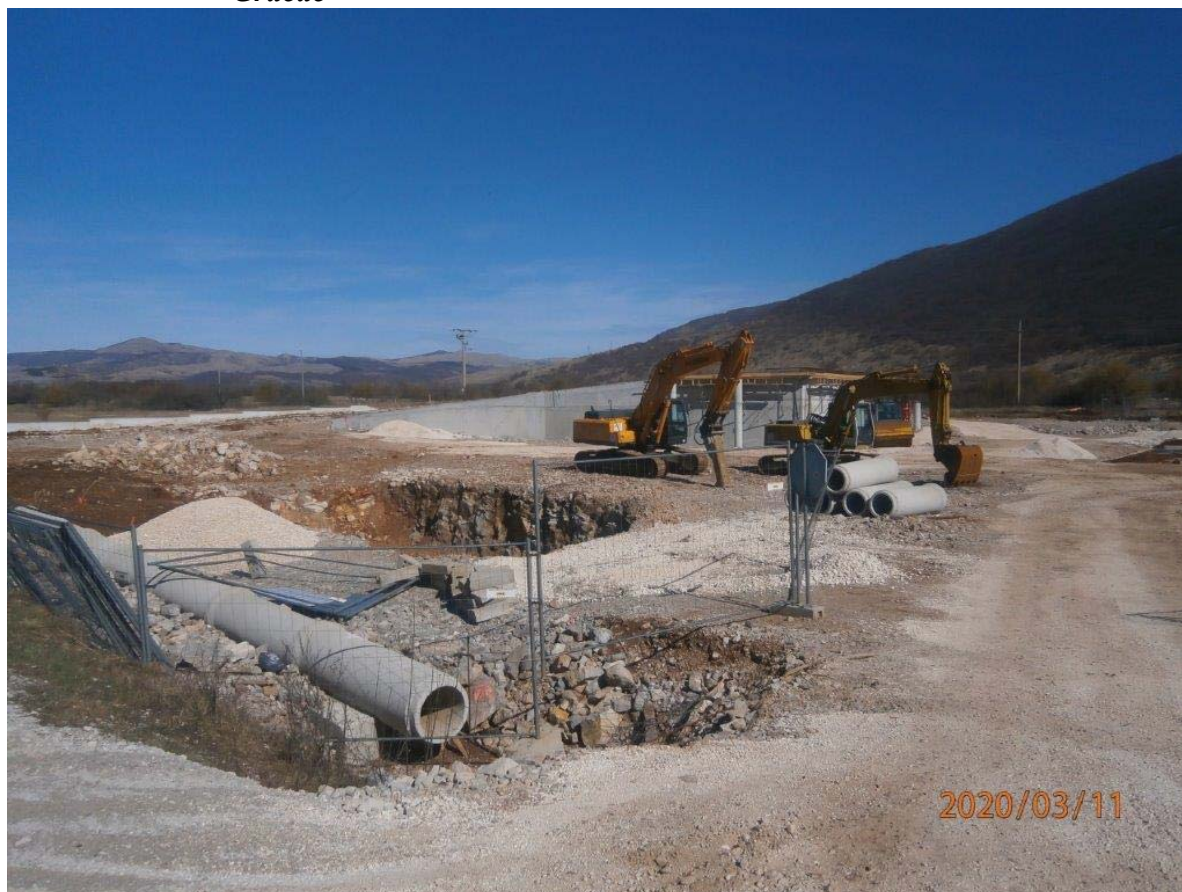
Slika 10: Izvođenje pripremnih radova izgradnje reciklažnog dvorišta Gračac
