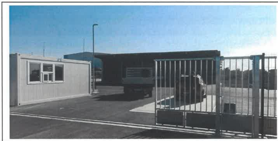
Slika 2. Izgrađeno i stavljeno u funkciju reciklažno dvorište
